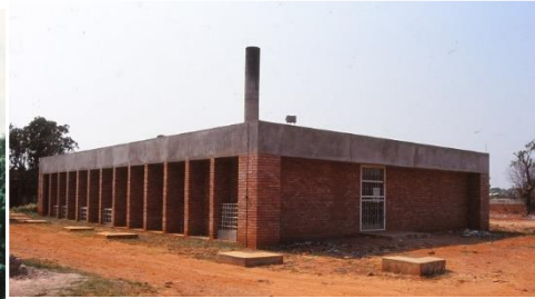
写真2 ウイルス実験棟 裏戸には白い防犯用鉄格子が見える
